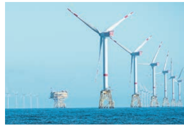
Рис. 11. Вітрогенератори, встановлені вздовж узбережжя Данії, повністю задовольняють потреби півночі країни в енергії та дозволяють продавати електроенергію іншим країнам
