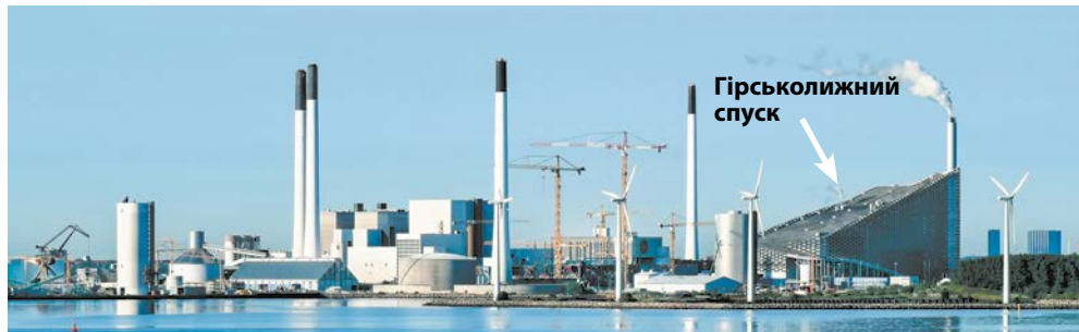
Мал. 38.3. Сучасний сміттєспалювальний завод Amager Bakke у Копенгагені перероблює сміття на теплову й електричну енергію і є місцем відпочинку
