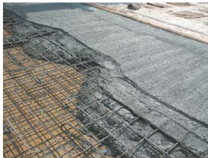
Мал. 30.10. Заливання арматурного каркаса бетоном
